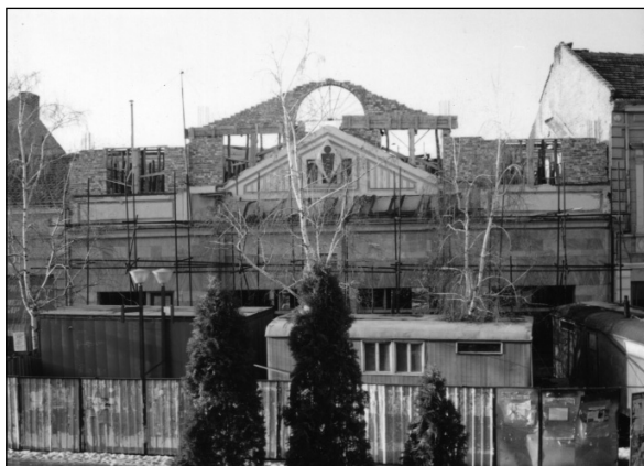
По време на строежа
